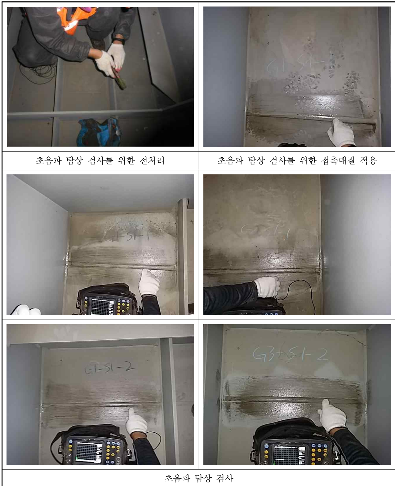
【사진 3.5.1】 강재 내구성조사 전경
