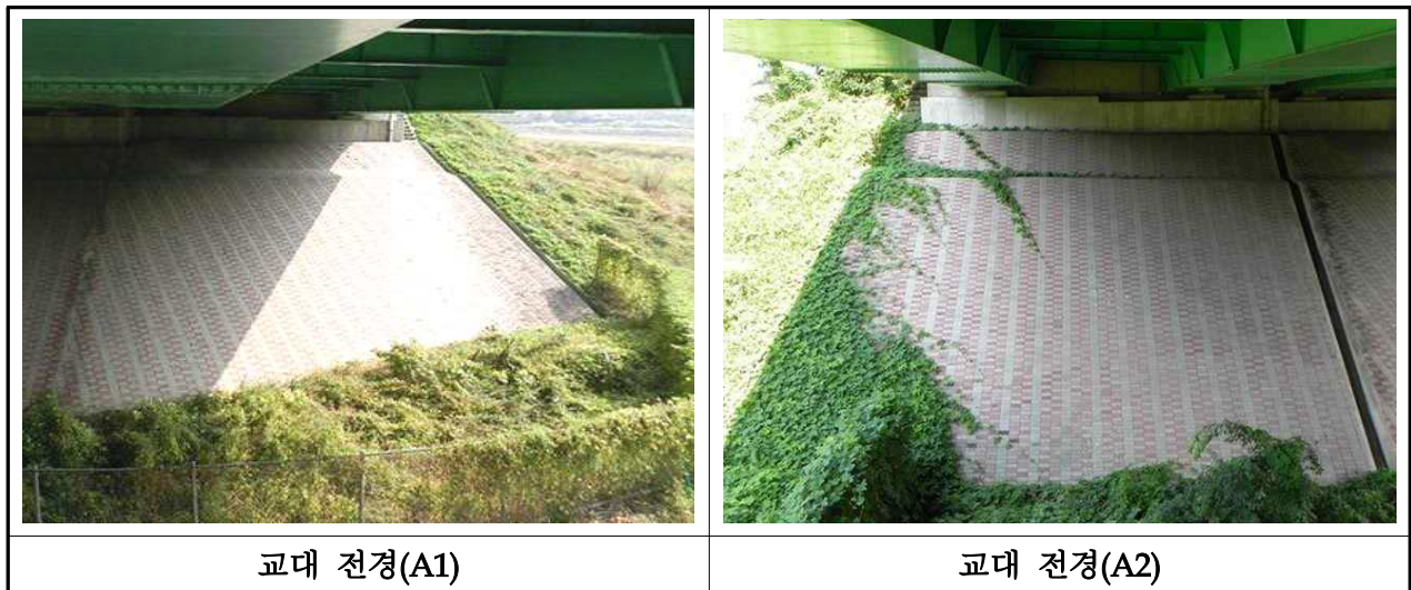
【사진 3.3.4】 교대 전경(부산)
