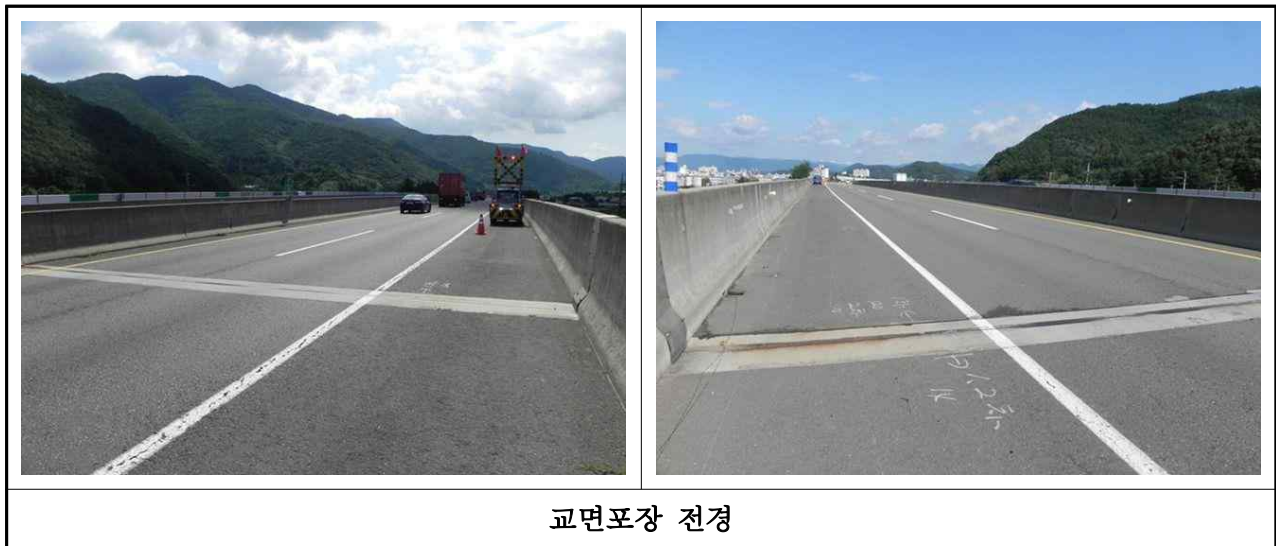
【사진 3.3.14】 교면포장 전경(부산)
