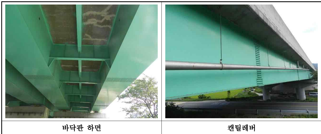
【사진 3.3.1】 바닥판 전경(부산)
