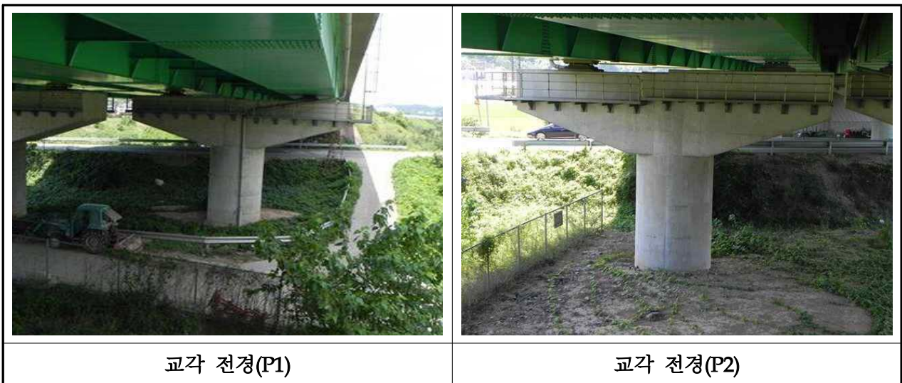
【사진 3.2.6】 교각 전경(대구)
