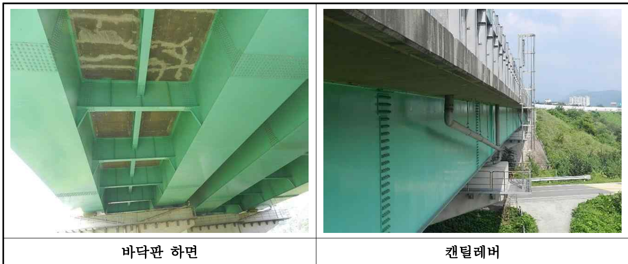
【사진 3.2.1】 바닥판 전경(대구)
