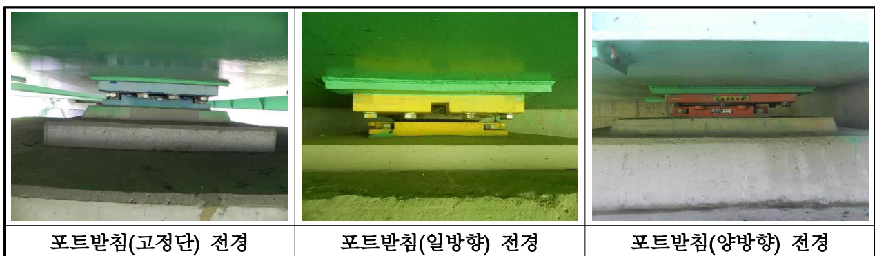
【사진 3.3.8】 교량받침 전경(부산)
