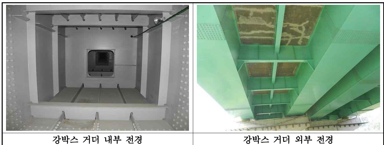
【사진 3.2.2】 강박스 거더 전경(대구)
