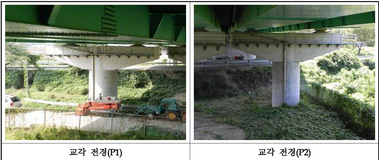
【사진 3.3.6】 교각 전경(부산)
