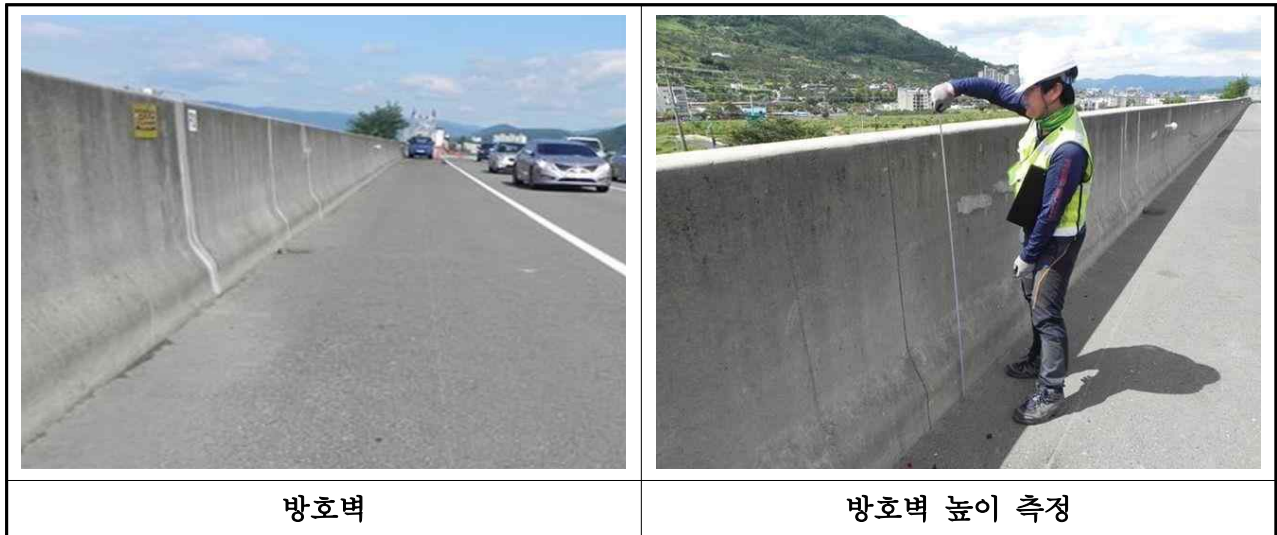
【사진 3.3.17】 난간 및 연석 전경(부산)
