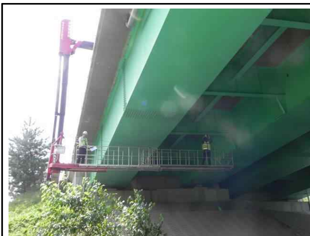
교량점검차를 이용한 조사
