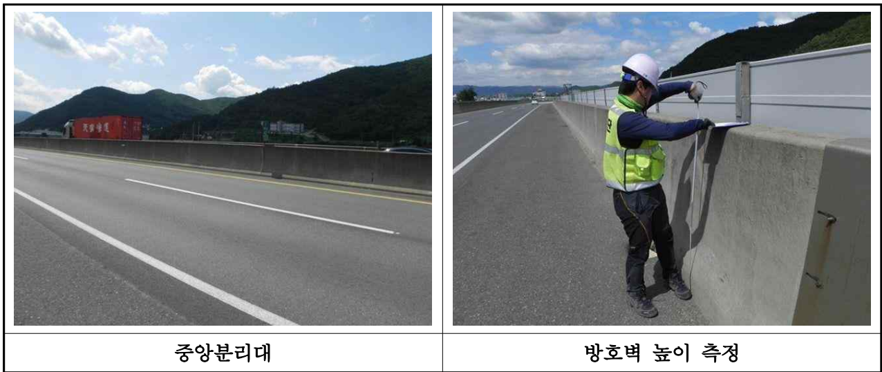
【사진 3.2.17】 난간 및 연석 전경(대구)
