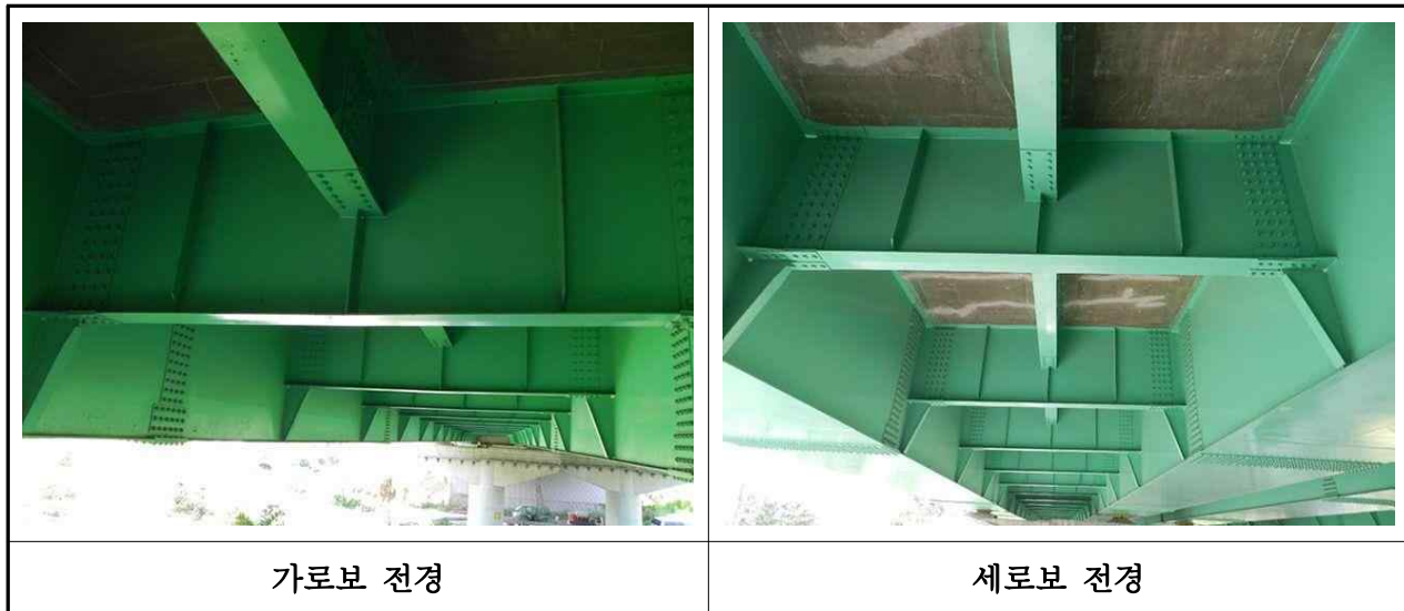
【사진 3.2.3】 가로보 및 세로보 전경(대구)
