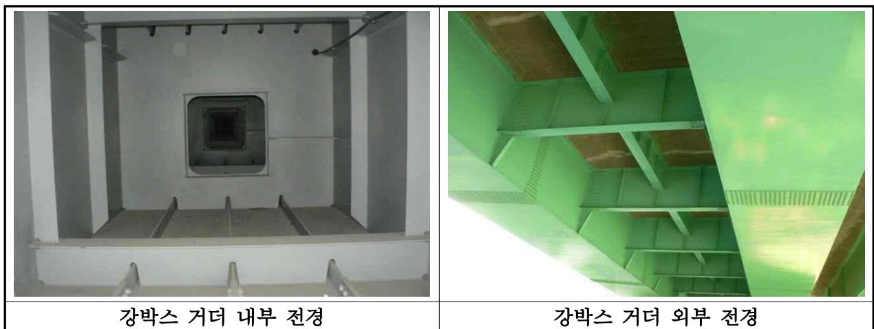
【사진 3.3.2】 강박스 거더 전경(부산)
