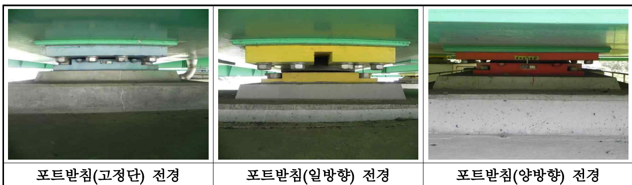
【사진 3.2.8】 교량받침 전경(대구)
