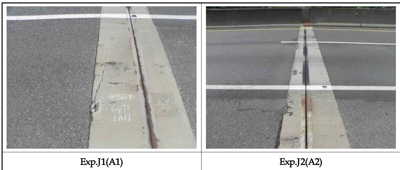
【사진 3.2.11】 신축이음장치 전경(대구)
